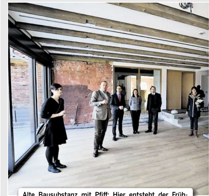
Alte Bausubstanz mit Pfiff: Hier entsteht der Frühstücksraum des „Yard“. Photowerk (bas/3)
